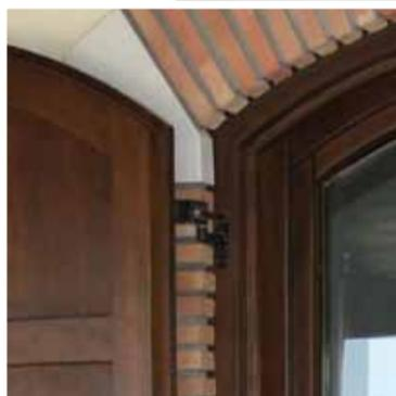
Telaio: 68x70 mm - Anta: 68x80 mm
