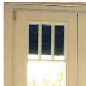
Telaio: 56x70 mm - Anta: 56x80 mm
