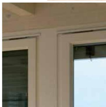
Telaio: 92x90 mm - Anta: 92x90 mm
