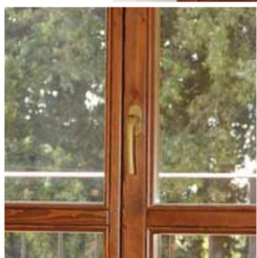
Telaio: 56x70 mm - Anta: 56x70 mm
