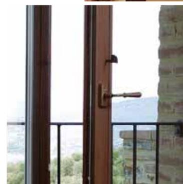
Telaio: 68x80 mm - Anta: 80x85 mm
